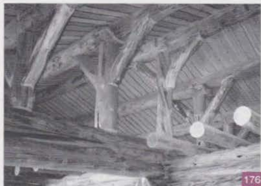
Série de contrefiches en "arbre de vie" pour soulager des pannes de forte portée.
