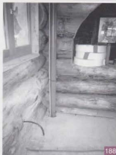
Rondins percés pour passage d'un câble RO2V qui sera gainé
