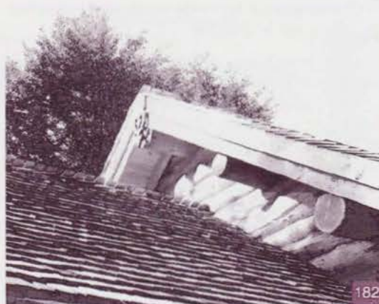
Couverture en bardeaux de châtaignier fendus (Ets Richard, Bénévent l'Abbaye)
