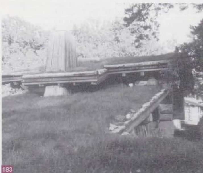
Toiture-prairie : une toiture lourde qui contribue à renforcer le jointage des rondins, et qui stocke du carbone.
