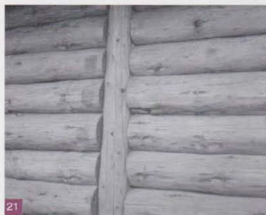
Un poteau: une solution pour réaliser un mur long sans refend.
