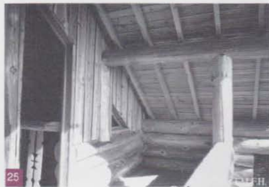
Avancée de toit sur un balcon : les pannes en bois rond doivent supporter le poids des composants du toit et de la neige
